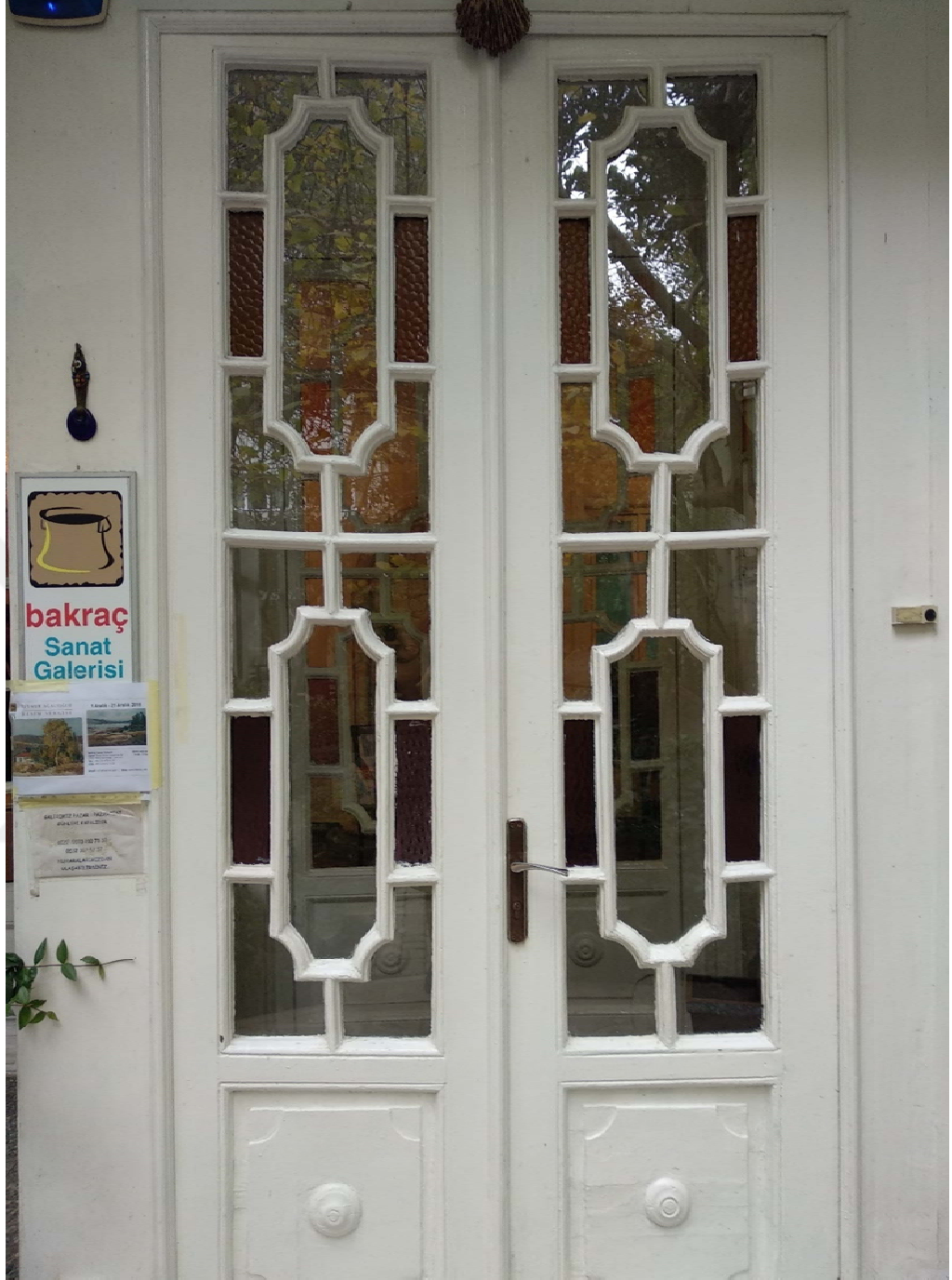
Foto 3: Bakraç Sanat Galerisi Dış Kapı Detayı
