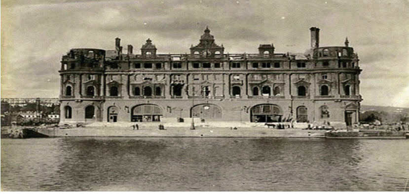
EK2: İnfilâktan sonra Haydarpaşa istasyon binası
