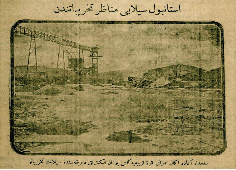
Resim 3: Selin Silahtarağa Elektrik Fabrikası'nda Yarattığı Tahrifat ( Tasfir-i Efkâr , nr. 889, 3 Ekim 1913, s. 1.)
