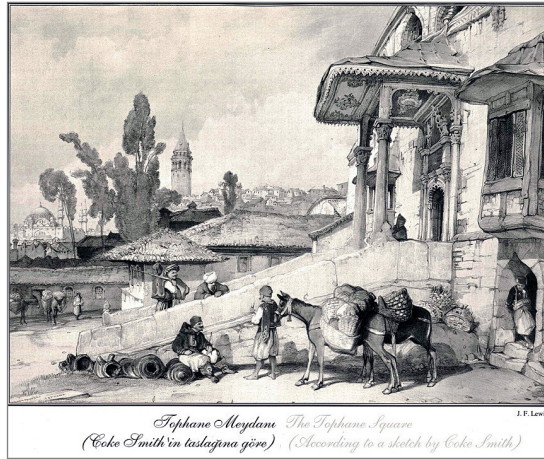
Resim 5. Tophane Meydanında Bulunan Topçubaşılık Binası. 47
