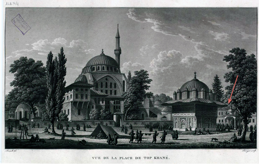
Resim 8. Topçu Ocağı Nazırı'nın Tophane Çeşmesi'nin Arkasında Bulunan İdari Binası. 59
