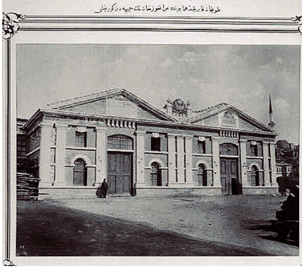
Resim 17. Tophane-i Âmire Fabrikalarından Marangozhane'nin Cepheden Görünüşü. 84
