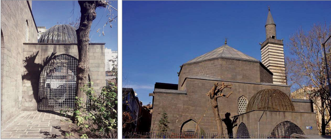
Figür 11 - Zübeyde Hanım Türbesi, Diyarbakır
